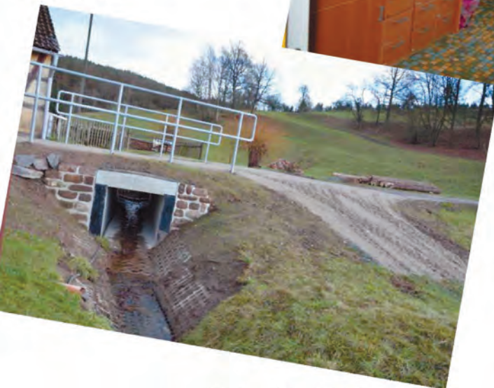
• Neubau Durchlass/Brücke in Langschade/Reichenbach nach Hochwasser
