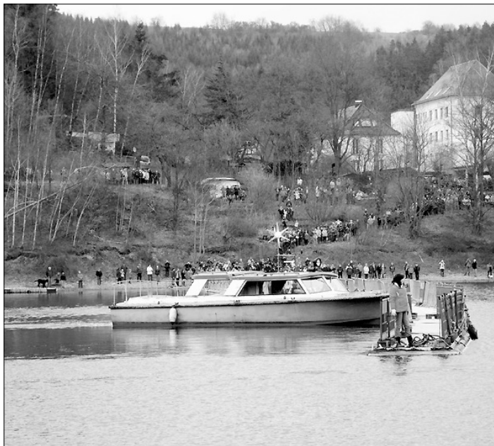
Die Brücke wird eingeschwenkt
