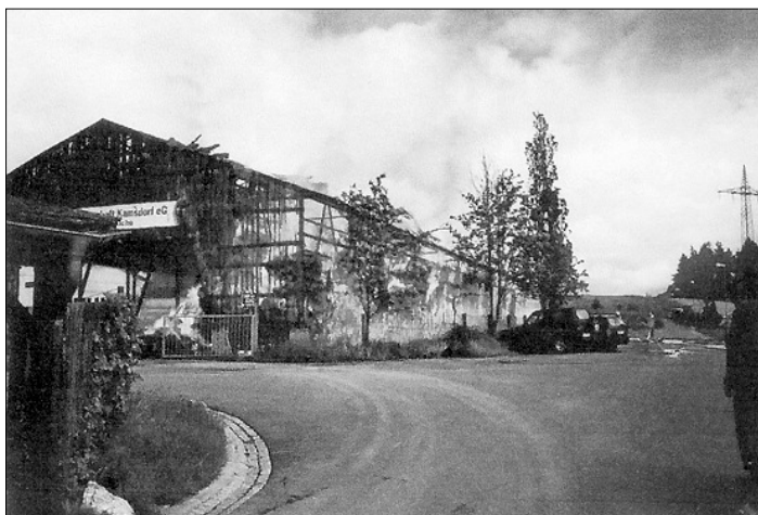
Feldscheune in Bucha am 30. Mai 2006 niedergebrannt Feuerwehren verhindern ein Ausbreiten des Brandes
